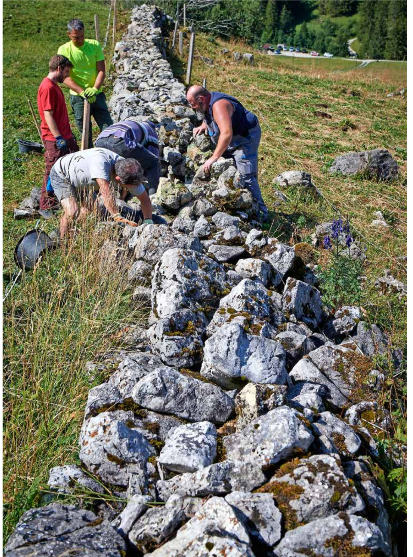
Alle müssen aufeinander schauen beim Wiederaufbau der Mauer.
